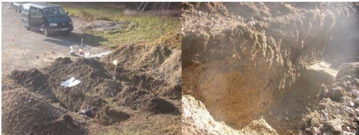
Рисунки А4-2а и б: ямы шурфа на участке «подъезд к бывшему стрельбищу UniBwM» (UNiSd-Sch1 и UniSd-Sch2).
