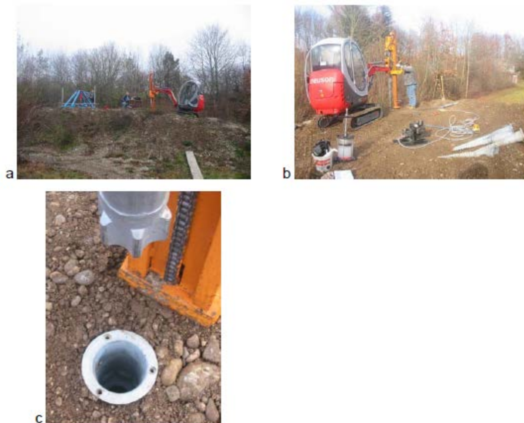
Рисунок А9-6: испытания на территории «бывшего тира» UniMwM в Нойбиберге, отвал из местного гравия бывшего строительного объекта (участок «UNIHI») с прибором для ввинчивания, испытательный прибор (а), тензиметр, легкий динамичный зонд, фундаментный винт (b) и фундамент винт, недавно введенный в грунт.
