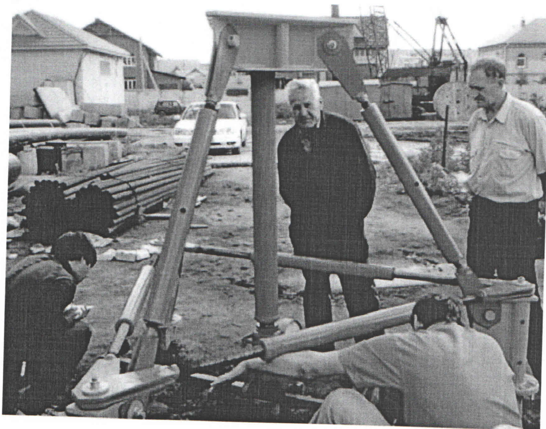
Фото 12 – Испытание свай на вдавливающую нагрузку
