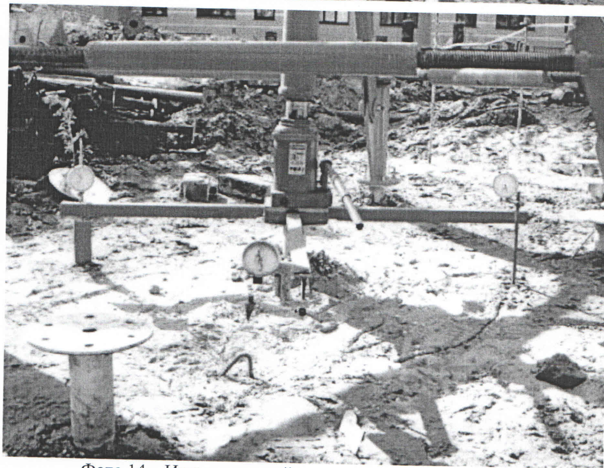
Фото 14 – Испытание свай на вдавливающую нагрузку
